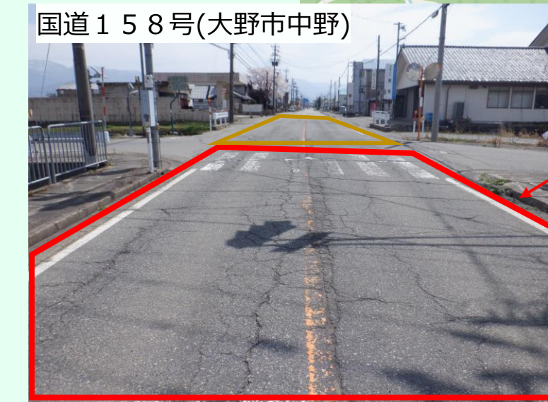
▼ 舗装損傷 AI判別結果イメージ
