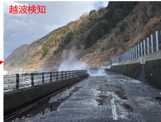
越波発生状況の画像を表示
