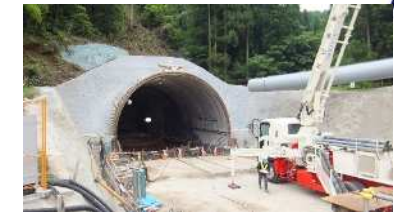
⑮ 国道417号（板垣坂バイパス）池田町側の状況
