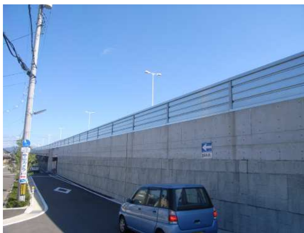
遮音壁の設置による道路騒音対策
