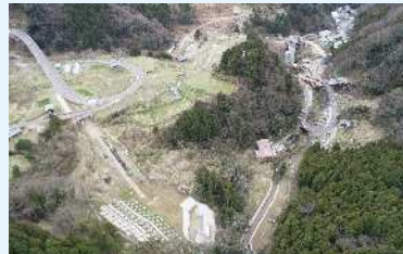
⑪ 国道365号（梅浦バイパス）の状況
