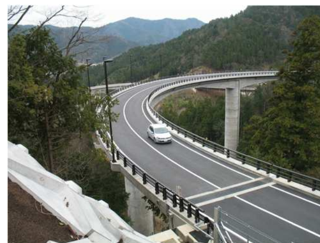
石山3号橋(整備後)
