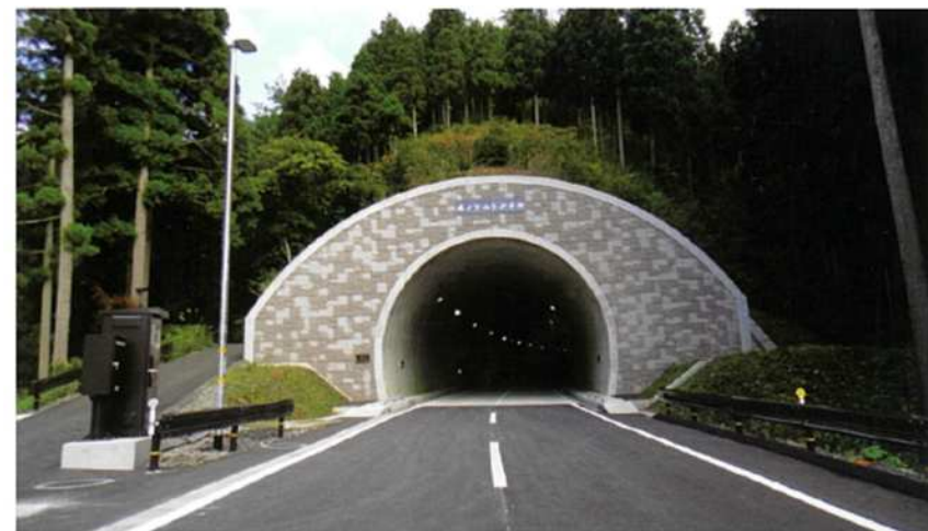
河内側坑口(旧河野村)
