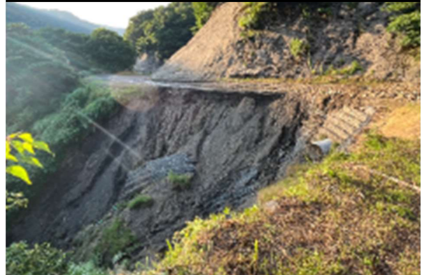
【写真②】R4. 8月大雨による被災状況
