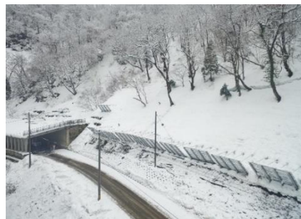
国道417号冠山峠付近の雪崩対策 (池田町河内)
