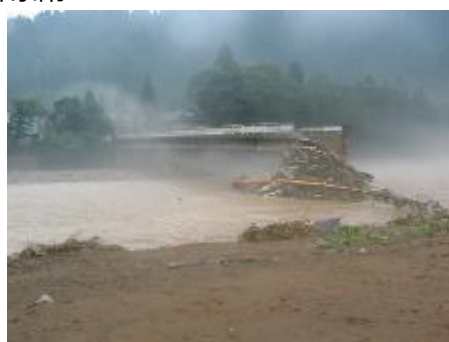
足羽川 被災状況
