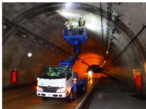
国道 158 号 小和清水・奈良瀬トンネル (福井市美山町)
