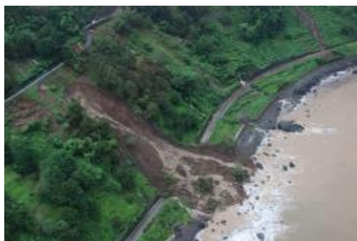
国道305号 法面崩壊(福井市居倉町)
