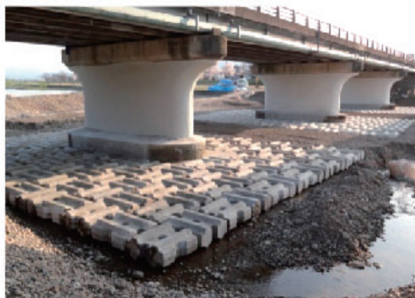
橋梁耐震補強工事 (万代橋)
