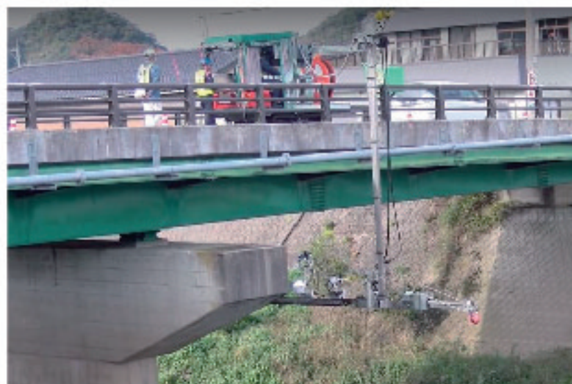
橋梁点検 (舞屋橋)
