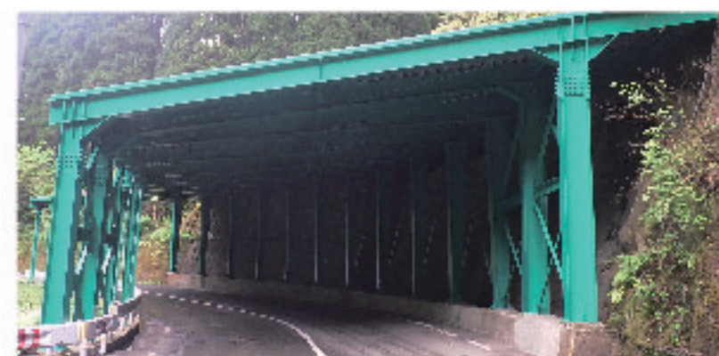
スノーシェッド補修
