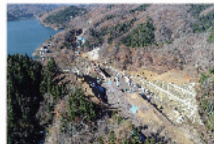
箱ヶ瀬地区施工状況
