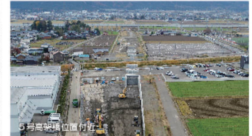
現況写真 (R5.12月時点)
