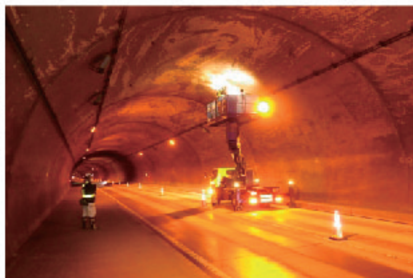
トンネル点検 (小和清水奈良瀬トンネル)
