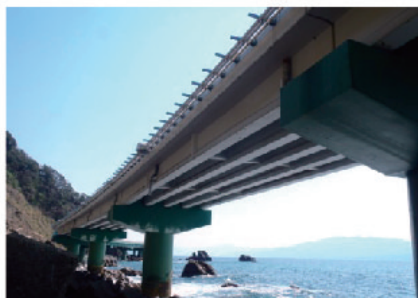
橋梁補修工事 (河野大橋)
