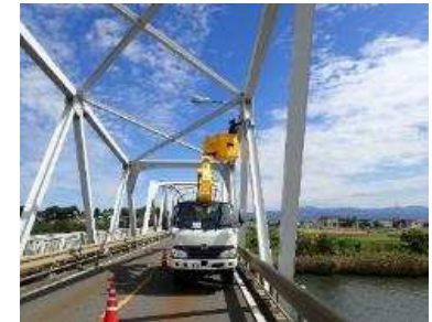
橋梁の定期点検
