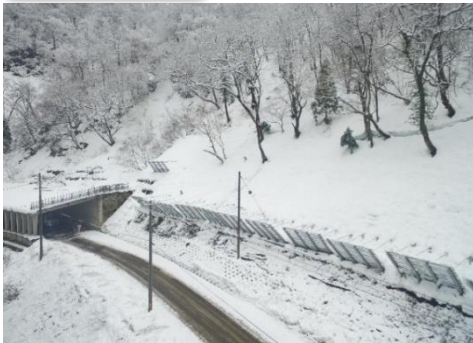
国道417号冠山峠付近
