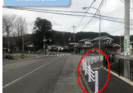
敦賀美浜線（敦賀市金山）
