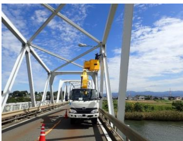
橋梁の定期点検（新保橋）
