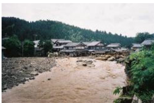
一乗谷川 被災状況
