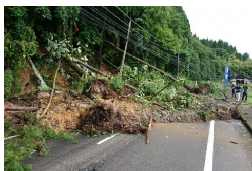
国道365号 法面崩壊(越前町下河原)
