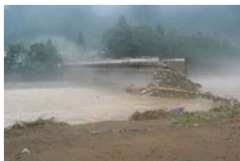
足羽川 被災状況
