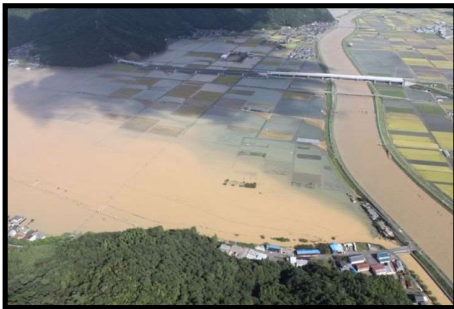
ダム完成前の浸水状況 (平成25年9月台風18号)
