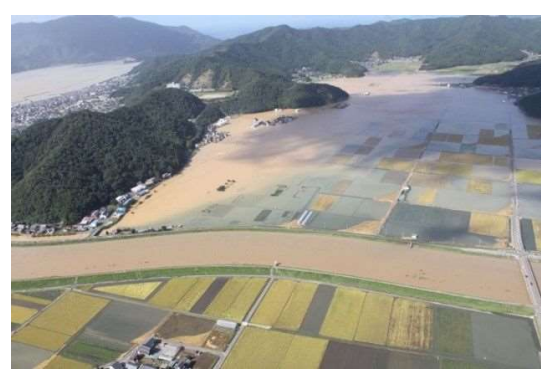
改修前浸水状況(平成25年9月台風18号)
