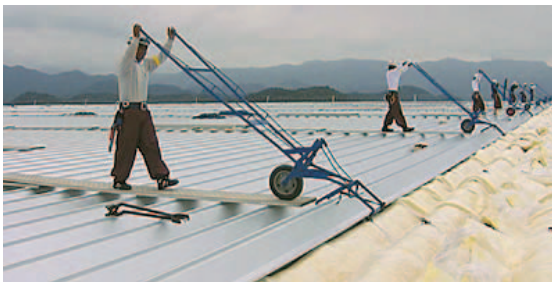
ダブル折板の施工風景
