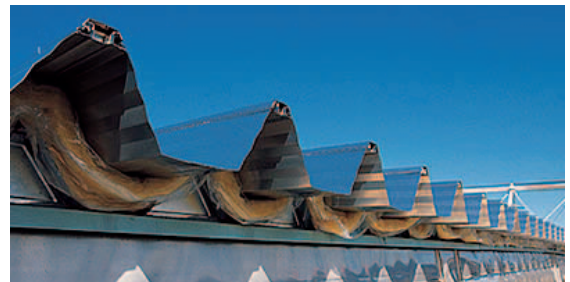
ダブル折板の施工風景
