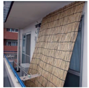
出典：ダイキン HP 室外機の日除け
