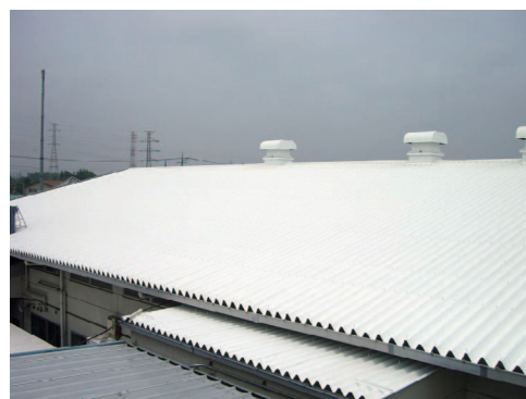
遮熱塗料の施工状況 出典：ミラクール HP
