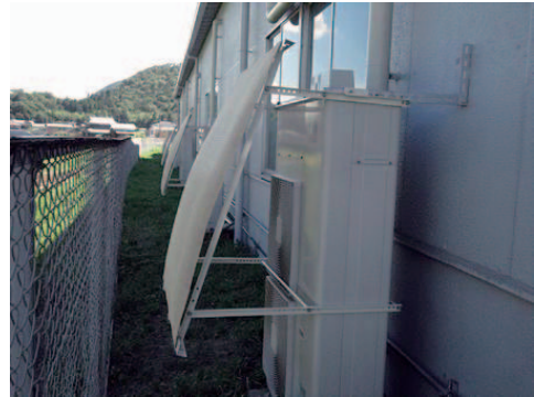
〈室外機への日除け取付け〉
