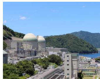
2022年 原子力由来電力によるCO2フリー水素製造実証
