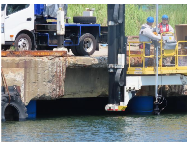
水中3D計測装置 装着治具
