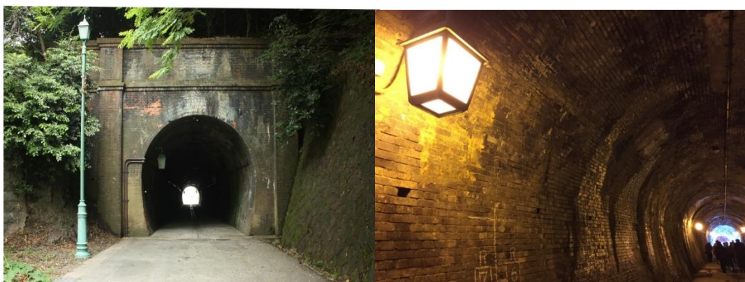
4 檜曲トンネル
