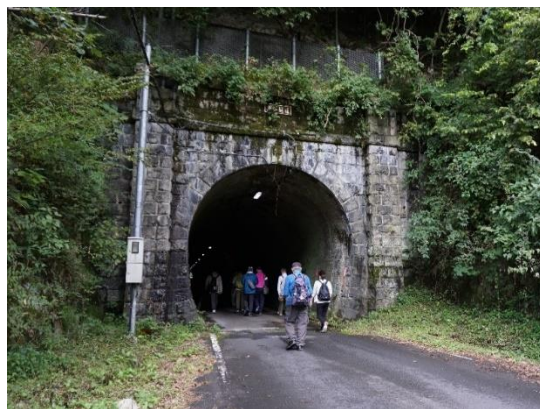
12 曲谷トンネル
