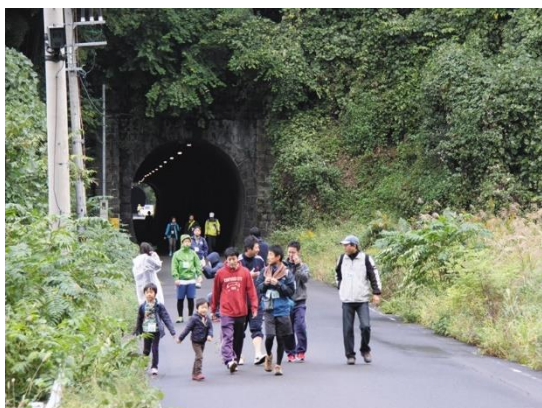
13 芦谷トンネル
