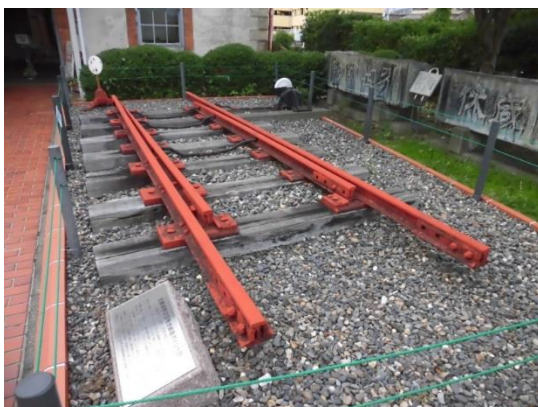
31 旧長浜駅 29号分岐器ポイント部
