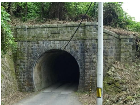
7 鮎ヶ谷トンネル
