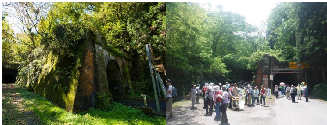
15 山中トンネル
