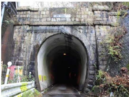
1 柳ヶ瀬トンネル
