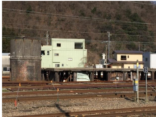
38 今庄駅給水塔・給炭台
