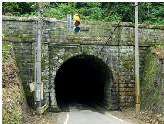
6 葉原トンネル
