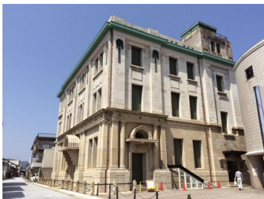
41 旧大和田銀行本店本館
