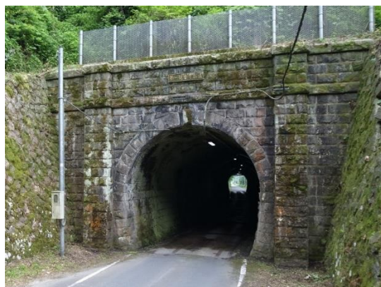
10 第一観音寺トンネル
