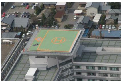
②福井赤十字病院 屋上離発着場
