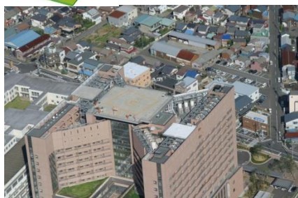
①福井県立病院 屋上ヘリポート
