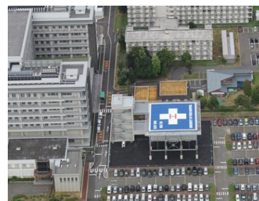
③福井大学医学部附属病院 場外離発着場【屋上】
