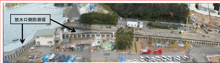
放水口側防潮堤
