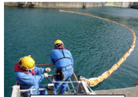
シルトフェンス設置
