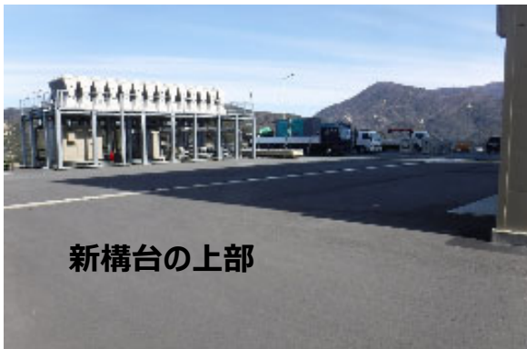
構台設置完了後の炉内構造物取替工事への引き渡し
