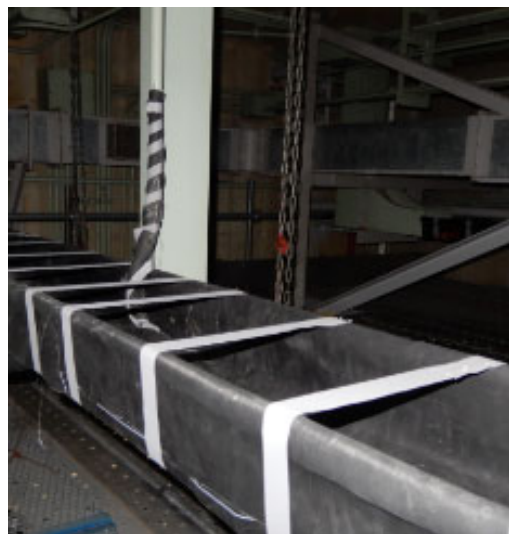
<防火シート施工箇所>
