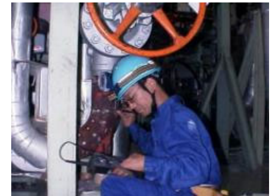
配管の厚み点検
