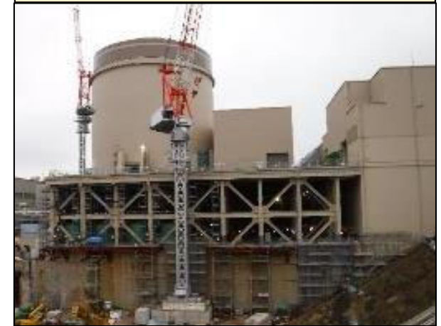
構台設置状況(2020.2)
