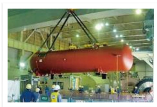
高圧給水加熱器の取替え
