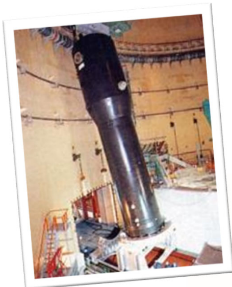
蒸気発生器の取替え
