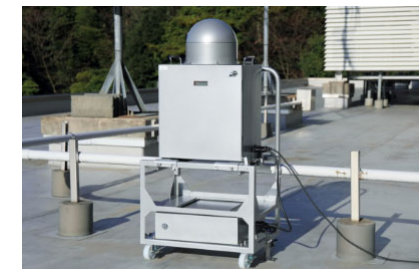
可搬型モニタリングポスト(例) [バッテリー付]
