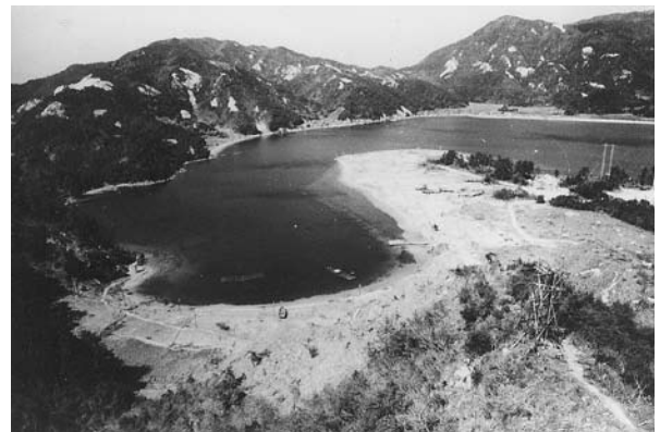
▲美浜発電所建設前の美浜町丹生地区
