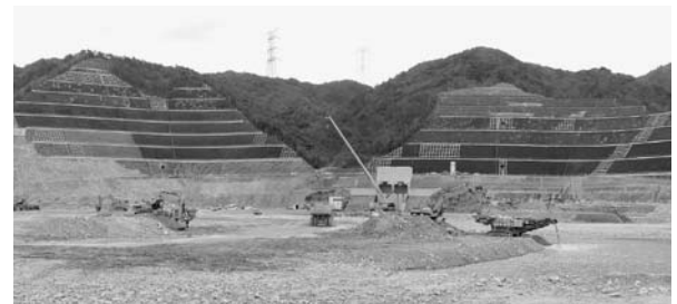
▲敷地造成背後山地全体状況(平成21年1月現在)
