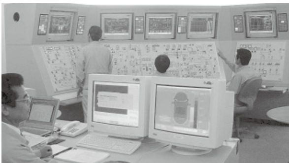
▲敦賀発電所2号機用小型シミュレータ
