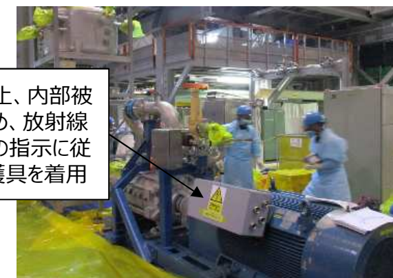
除染装置の組み立て
