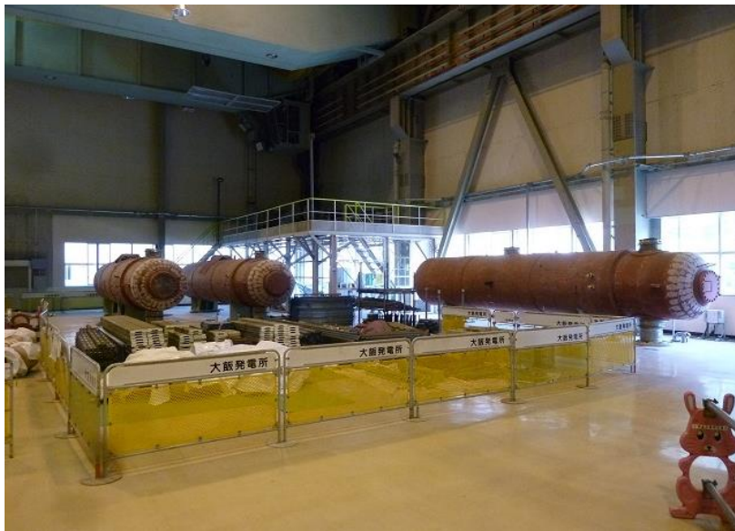
タービン建屋 3 F 低圧給水加熱器撤去前
