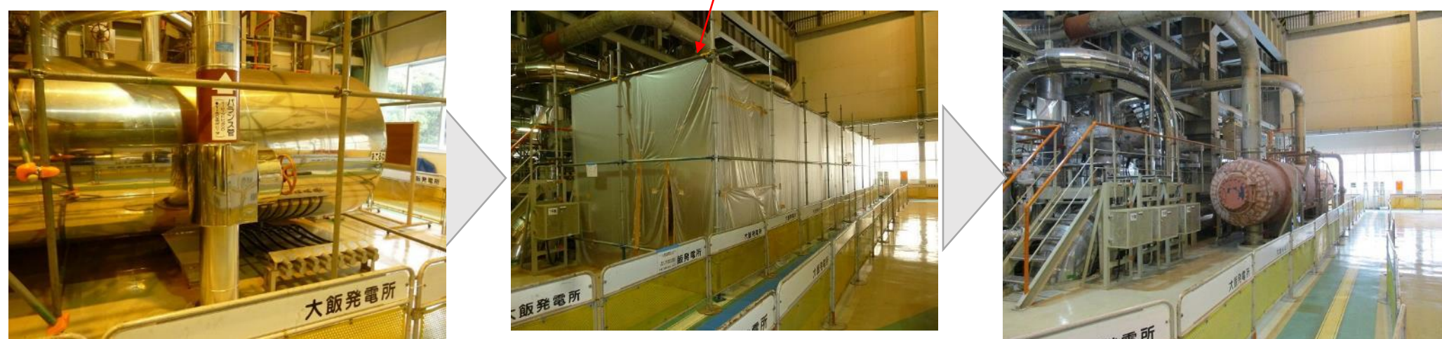
粉じん飛散防止養生実施
