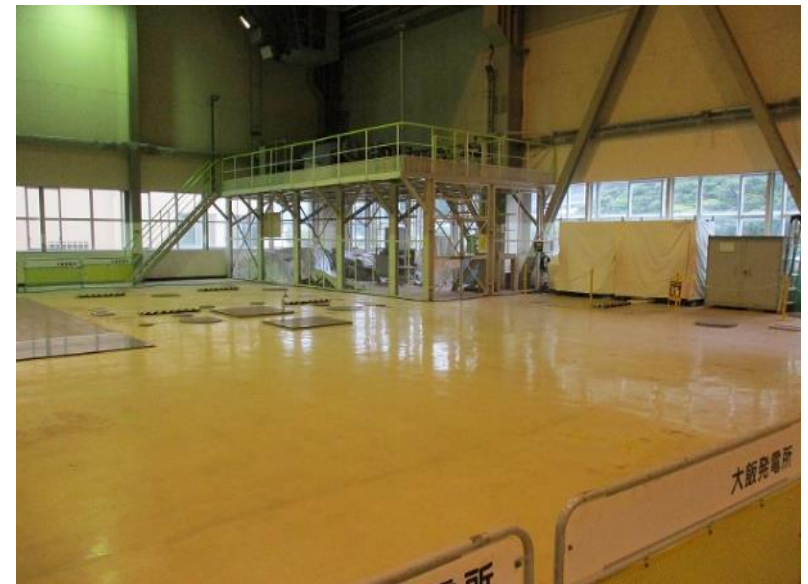
タービン建屋 3 F 低圧給水加熱器撤去完了
