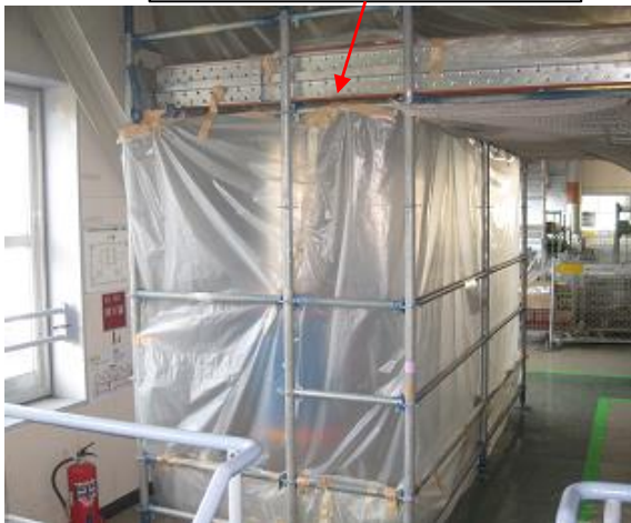
粉じん飛散防止養生実施
