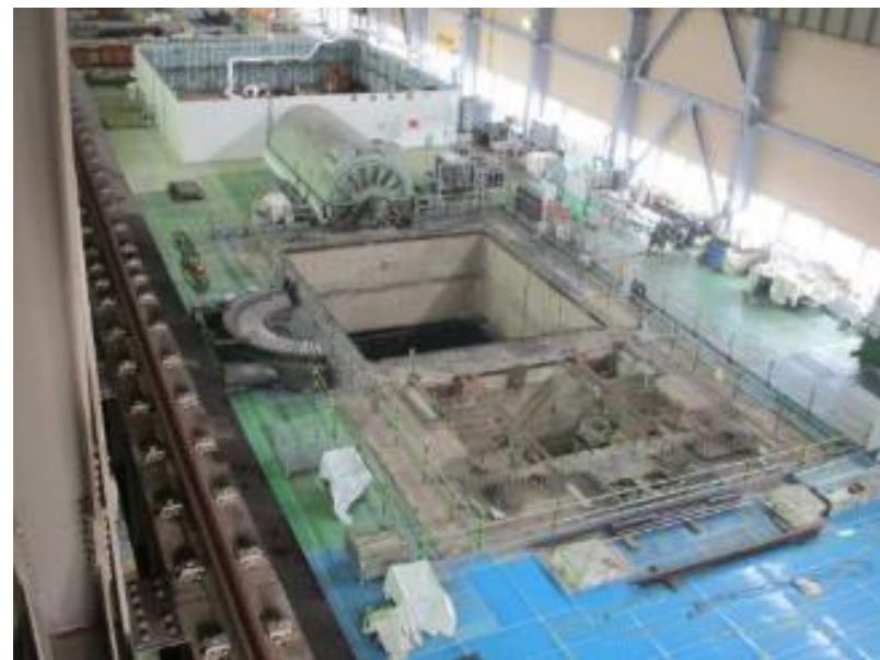
タービン建屋 3 F タービン撤去完了
