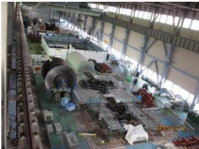
タービン建屋 3 F タービン撤去中
