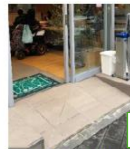
スロープの設置
