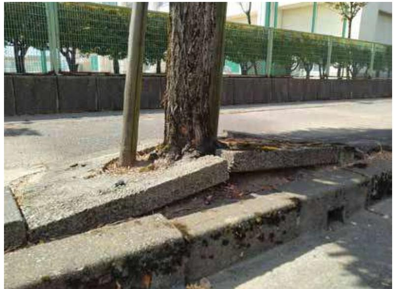
根上りによる植樹柵の破損（金津高校 通学路）
