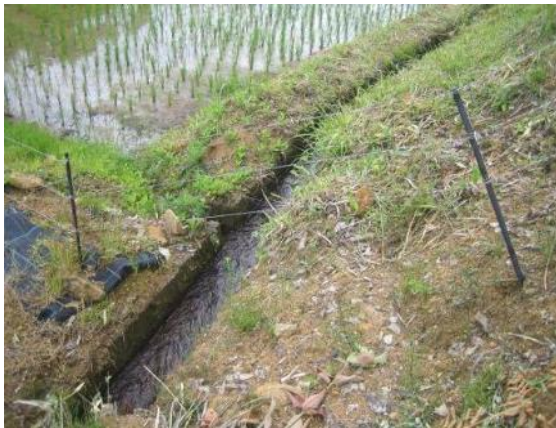
図 2 7 地形の変化点に支柱がなく、 電気柵と地面との隙間がある
