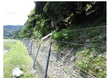
サル用電気柵の設置状況
