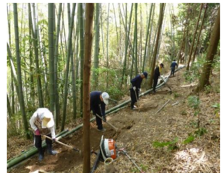
点検道の整備
