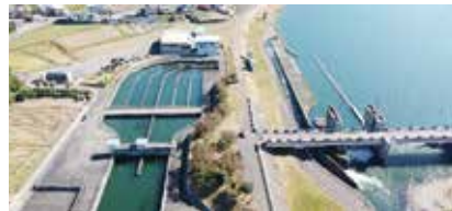
②九頭竜川下流 鳴鹿中央管理所 (坂井市)
