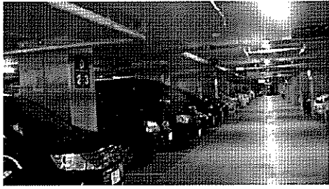
体育館地下駐車場
