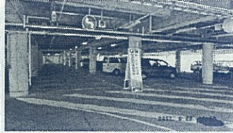
第1駐車場（サガミ橋下）
