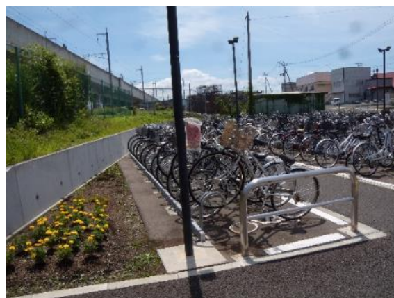
駐輪場の新設 (IGRいわて銀河鉄道 厨川駅)
