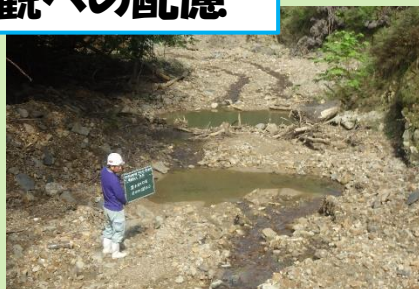
汚濁防止のための沈砂池設置
